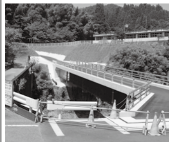
▲メンテナンス中津無礼橋上部
