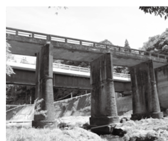
▲旧白山川河川プールの南側に架る中津無礼橋旧橋
