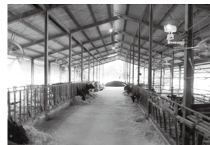
▲カラス撃退レーザーが設置された牛舎
