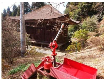
防災設備点検（神角寺）
