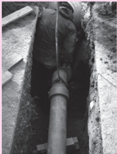
▲水道管工事の様子
