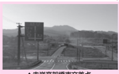
▲赤嶺高架橋南交差点
