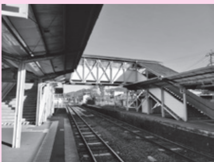
▲JR三重町駅の跨線橋
