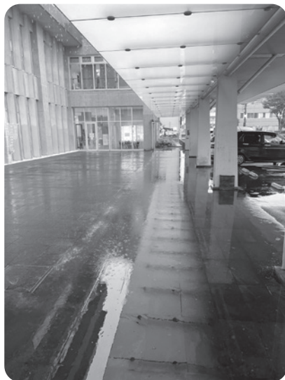
市役所庁舎前の透明屋根の下の通路
