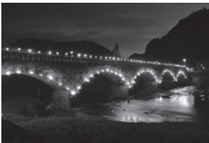
原尻昭和会の原尻橋（五連橋）
