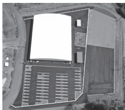
▲屋外トイレ、駐車場56台を整備しています。
