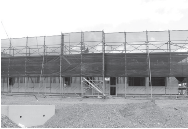
建設中の豊後大野市隣保館（大野町）
