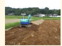
土層改良（客土）
