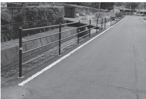
水路の転落防止柵（緒方町）
