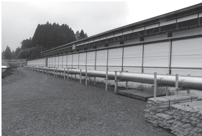
ダクトを設置して臭気軽減に取り組む養豚施設（清川町）
