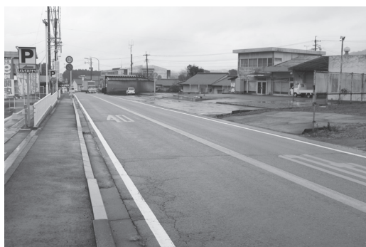
歩道設置予定の国道 326 号
