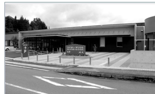
図書館・資料館の整備工事が行われました。
