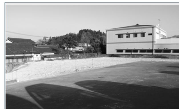
防災備蓄倉庫を新たに建設するため、市役所倉庫の解体工事が行われました。
