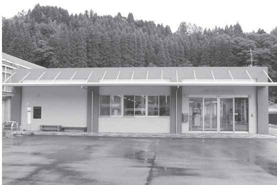
朝地町綿田の地滑りの際にも 災害対応をした朝地支所
