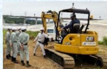
ICT建設機械による施工
