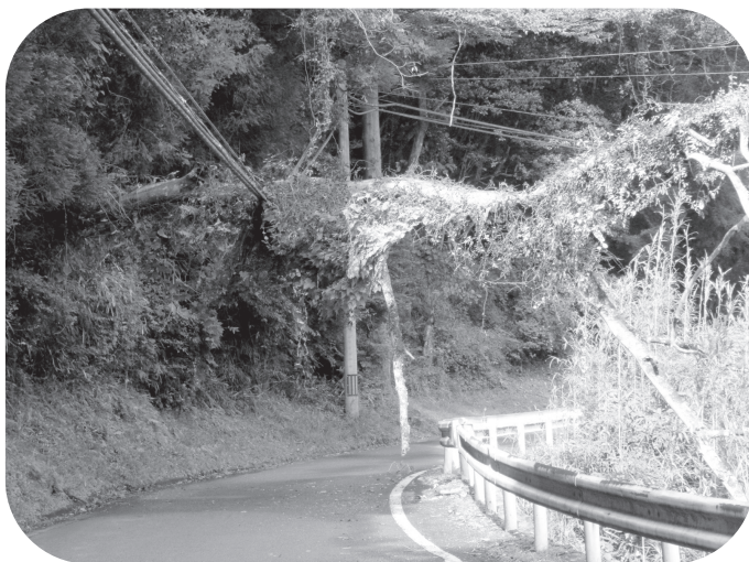
電線にも掛かり通行を妨げる支障木
