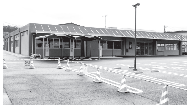
建設中の新大野公民館
