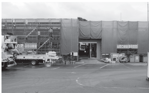
建設中の新犬飼公民館
