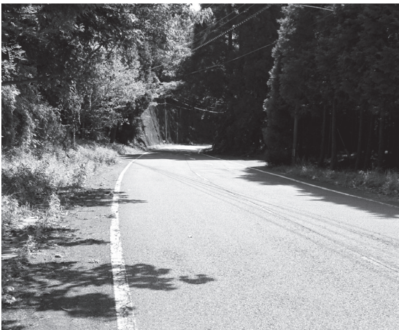
県道三重野津原線（藤北工区）
