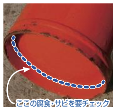
× 底部の腐食
