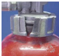
× キャップの破損
