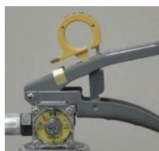
× 安全栓の抜けかけ
