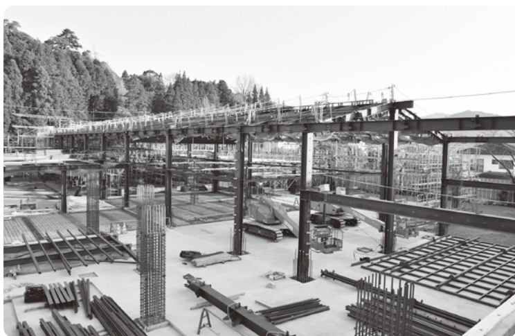
▲建設が進む新図書館・資料館
