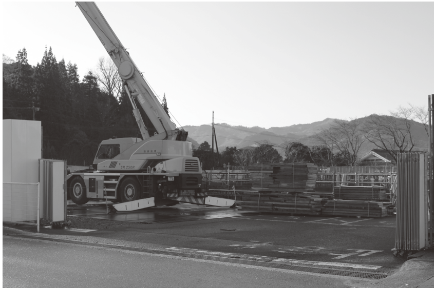
建設中の新図書館・資料館
