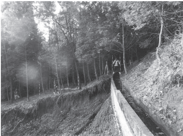
災害復旧現場
