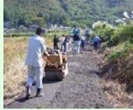
未舗装農道の舗装
