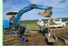
コンクリート水路の更新
