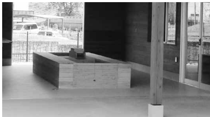
バイオマスボイラーを使った足湯
