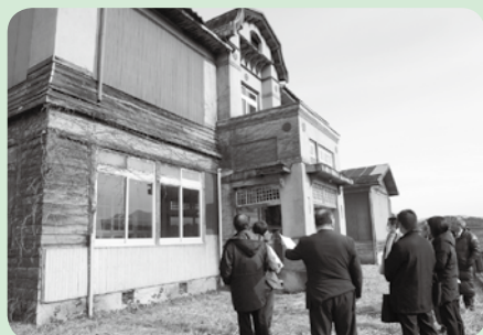
旧緒方町役場庁舎を現地調査
