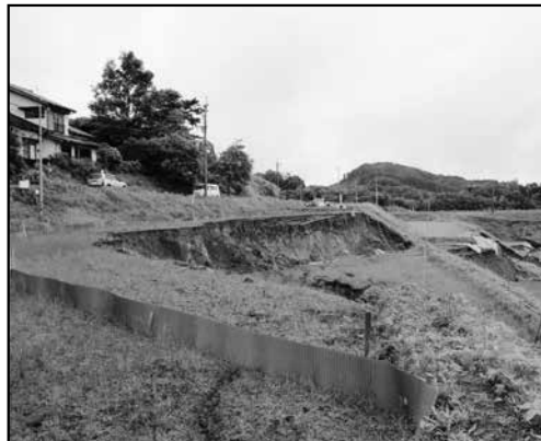
地割れが拡大 (6月28日 撮影)
