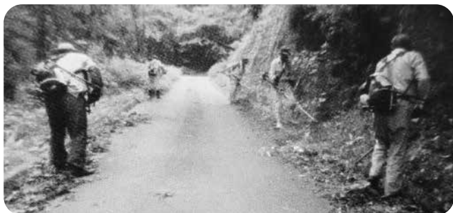
市道の除草作業
