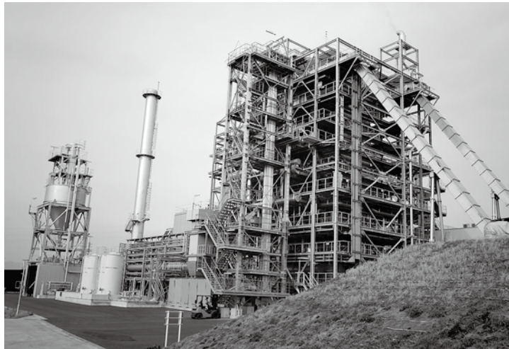
エフオン豊後大野が運営する木質バイオマス発電所(1月19日)
