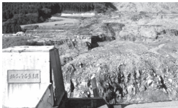
▲崩落した「阿蘇大橋付近」(現在も手つかずのまま)
