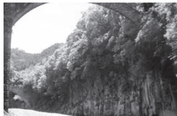
轟橋下方の崩落前
