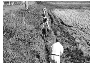
水路の泥上げ
