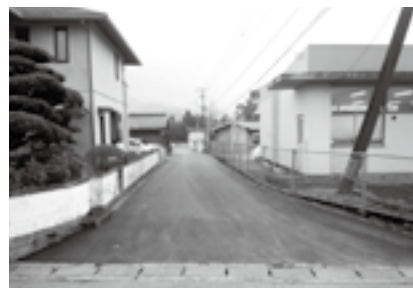
▲市道東保育所前線の舗装補修 （三重町の市立東幼稚園横）
