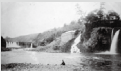
▲沈墮の滝と開業当時の発電所
