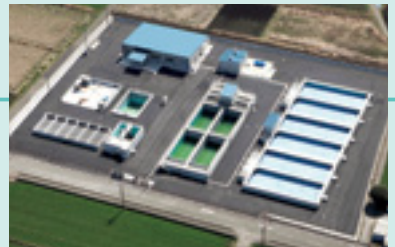
▲上空からの三重浄水場
