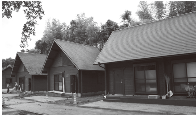
改修工事が進む井崎河川公園
