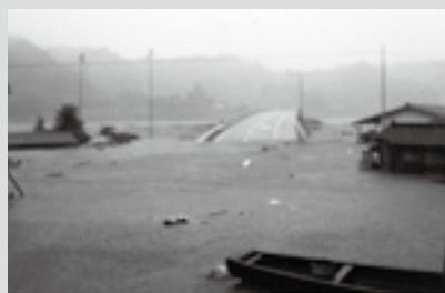
▲写真① 平成大橋周辺
