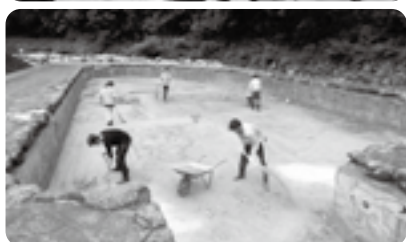
▲河川プールの土砂除去
