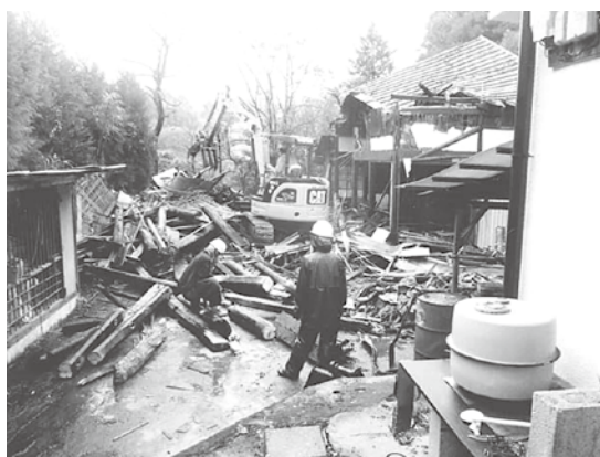
家屋解体工事
