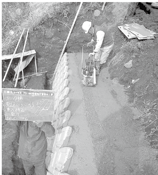
耕地災害復旧工事（朝地町）
