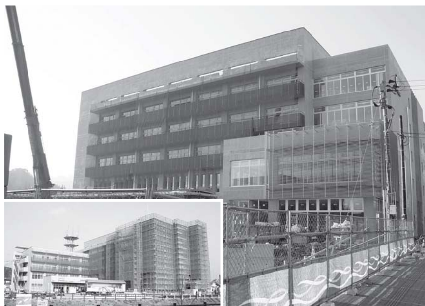
建設中の新庁舎
