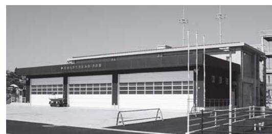
完成した豊後大野市消防本部・消防署
