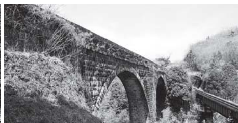
わかみや いろ ささむ たせつこうきょう 若宮井路 笹無田石拱橋
