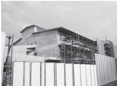
建設中の新三重中学校校舎
