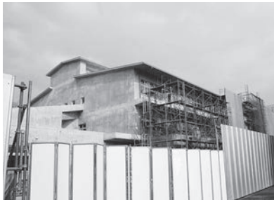
建設中の新三重中学校校舎
