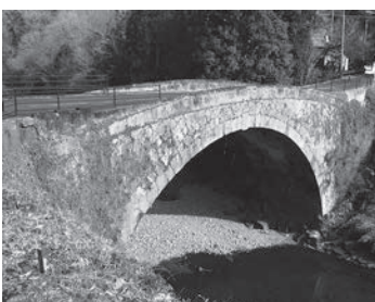
国指定重要文化財の虹潤橋 (三重町)
