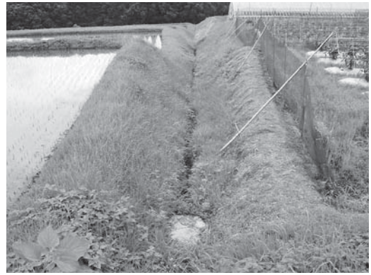
排水路工事 (清川町中村)
