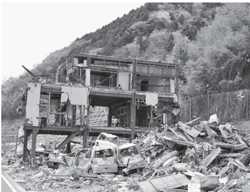
宮城県石巻市の被災状況（派遣職員撮影）
