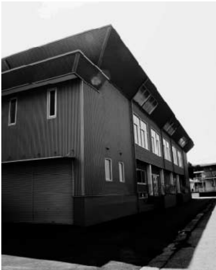
改築した三重第一小学校の体育館
