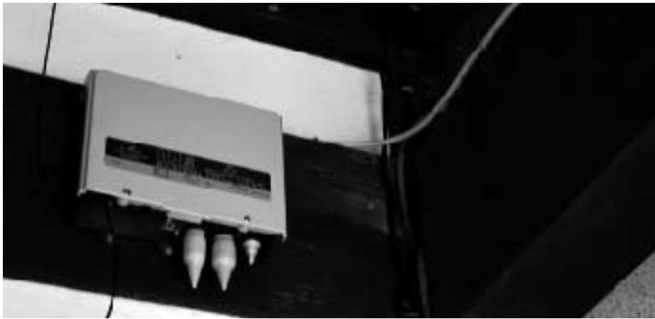
V-ONU (光回線終端装置/光信号を放送の信号に変換する機器)
