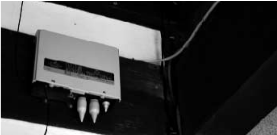
V-ONU (光回線終端装置/光信号を放送の信号に変換する機器)
