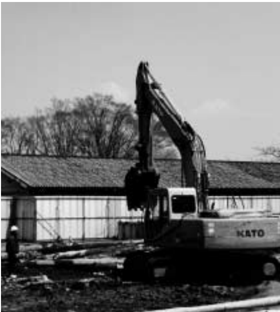
三重中学校の解体工事
