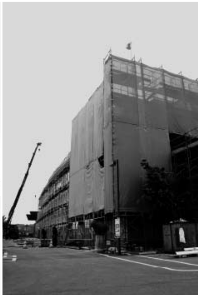
過疎債を利用して増床工事中（公立おがた総合病院）
