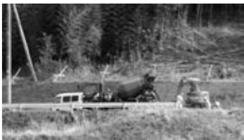
道路改良が進む千歳町長峰
