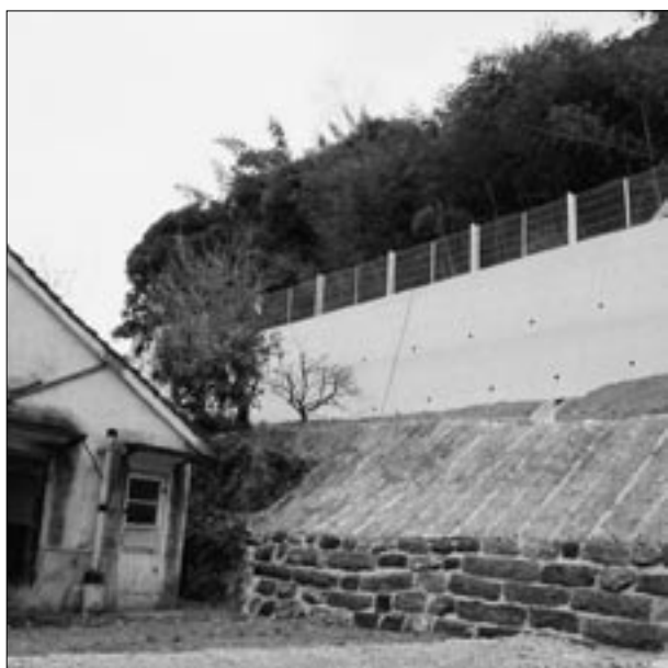
工事が行われている大野町河面地区
