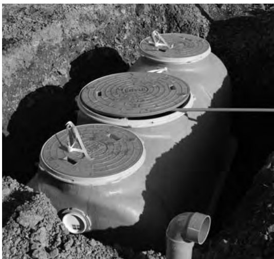
5人槽の浄化槽
