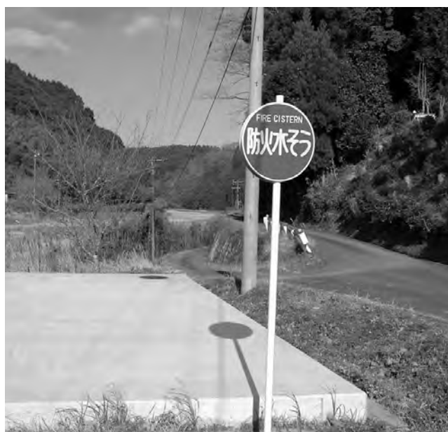
有蓋で整備された防火水槽
