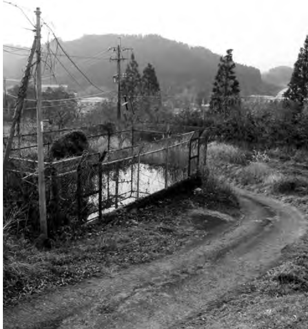
進入路が狭く、蓋のない防火水槽
