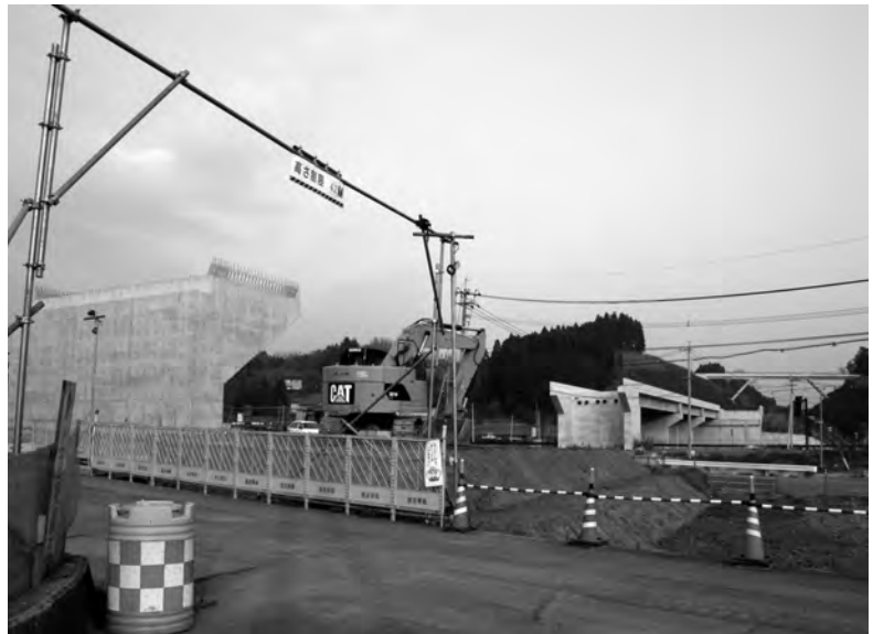
工事が進む大野インターチェンジ周辺
