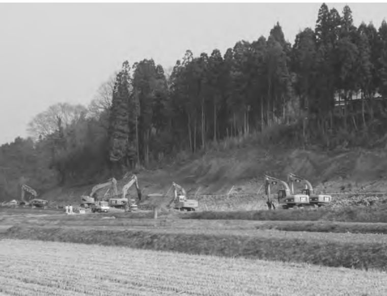
県道百枝・浅瀬・野津線 道路改良工事（三重町）
